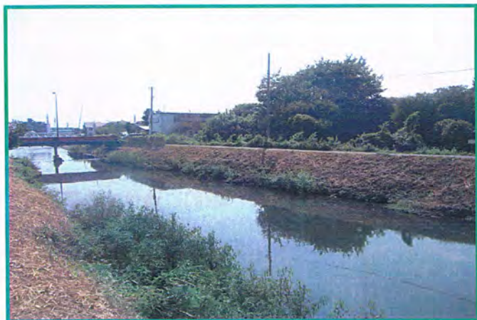
現在の護岸から (着工前)
