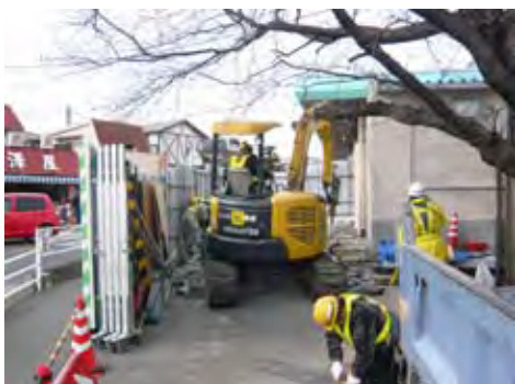
スロープ工事の様
