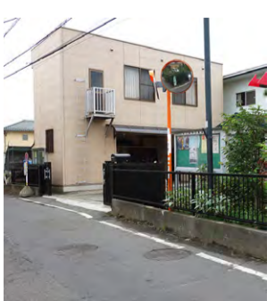
きれいになった正面フェンス
