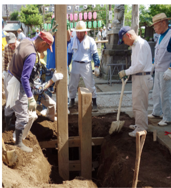
大幟用支柱を建立中
