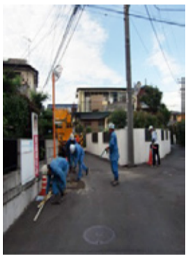
※電柱移設工事完了
