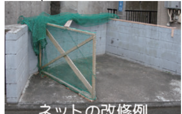
ネットの改修例
