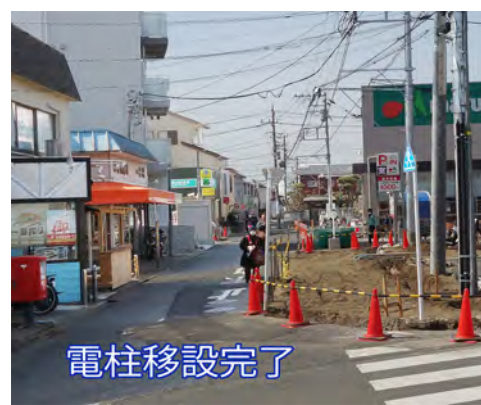
電柱移設完了
