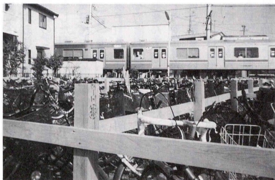
改修された駐輪場
