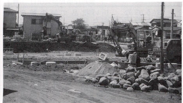
建設工事の進む現地
