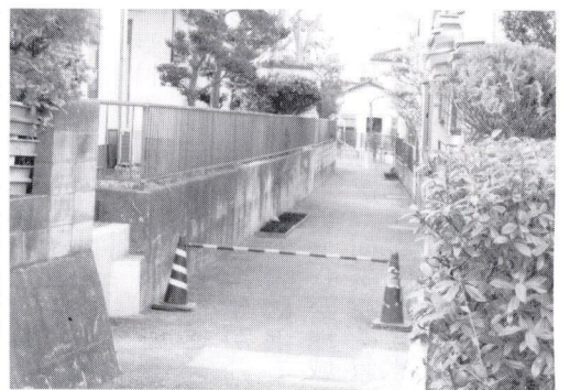
完成した散策路
