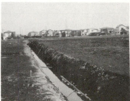
(素堀の排水路)
