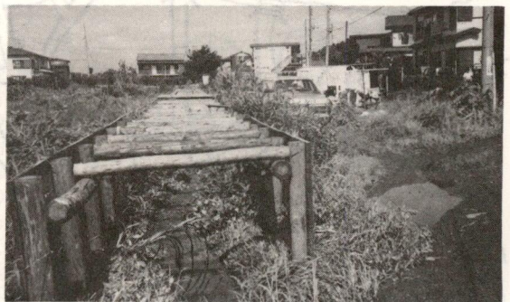
台風10号被害箇所
